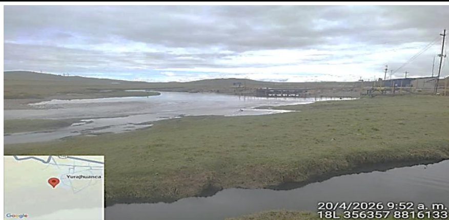
FIGURA N°01: INICIO DEL TRAMO CRÍTICO AGUAS ARRIBA SE ENCUENTRA LA ESTACION DE BOMBEO DE AGUA POTABLE DEL SECTOR YURAJHUANCA EN PELIGRO ANTE UNA COLMATACION EN EL PUNTO DE INICIO DEL TRAMO A DESCOLMATAR
